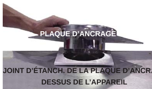
PLAQUE D'ANCRAGE POUR UNE CHEMINÉE PRÉFABRIQUÉE
